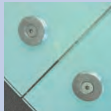
Spezialanfertigung Diebstahlsichere Wandhalterung aus Edelstahl.
